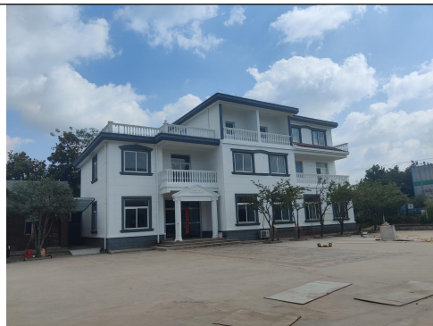
办公楼（废旧金属回收厂区）
