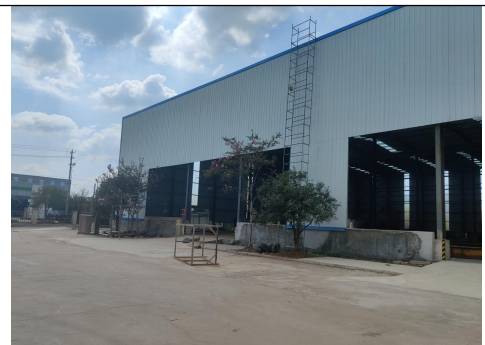
废旧金属处理回收厂房
