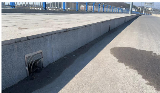
双湾大桥桥面径流收集设施
