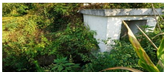
县医院泄洪闸
