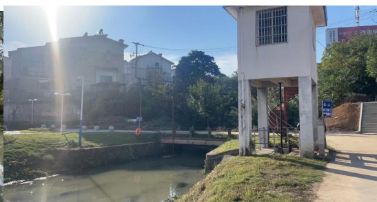
潜台渠泄洪闸
