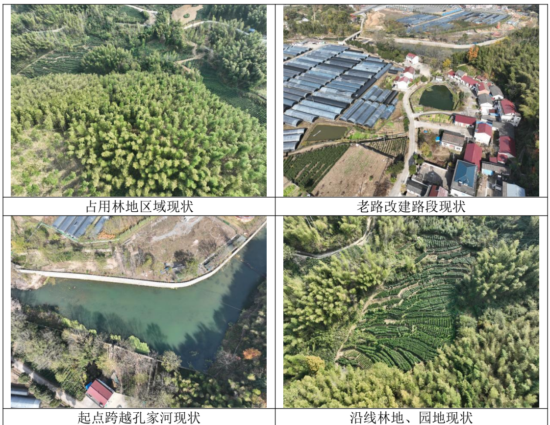
图 2-1 项目建设区域现状
