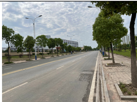
厂区外南侧纬六路
