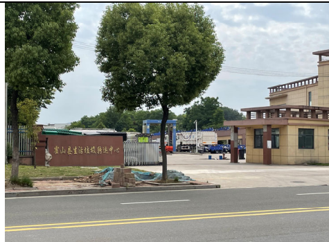
厂区外西南侧霍山县生活垃圾转运中心
