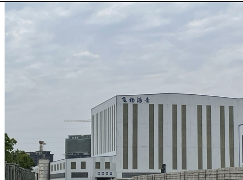
西北侧一信石其他项目生产厂房（原为飞扬生产厂房）
